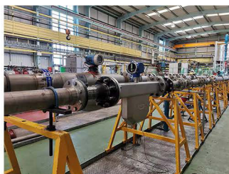
英国国家工程实验室（NEL）现场测试照片
